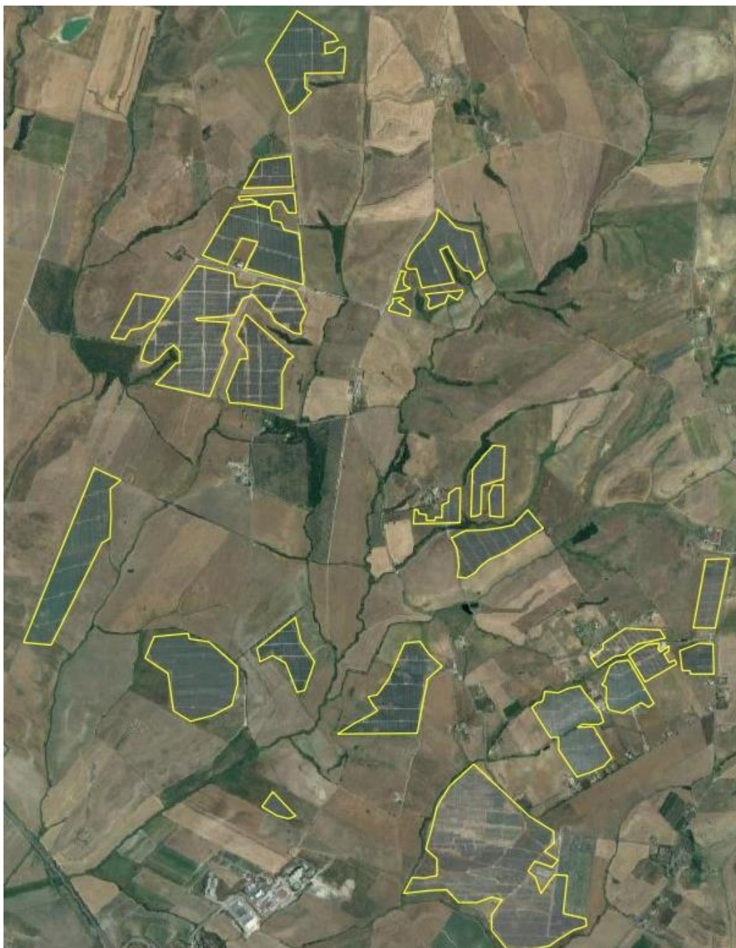
Figura 18. Esempio di impianti fotovoltaici installati su suolo utile (circa 370 ettari), comune di Montalto di Castro (Viterbo)
