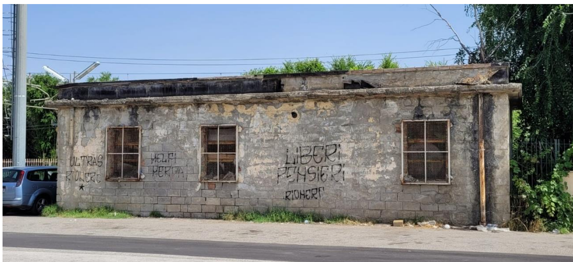
Figura 28. Un edificio abbandonato
